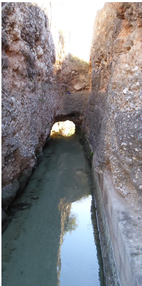
Mina Sèquia Particular Barranc de les Coves
