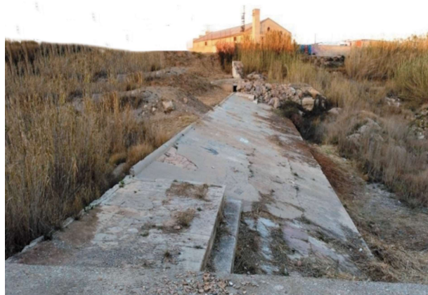
Ejemplo de estructura fosilizada. Azud de Rascanya, Valencia. Este dique data del siglo XV, momento en que se trasladó aguas arriba el original para dar riego a una mayor extensión de campos.
